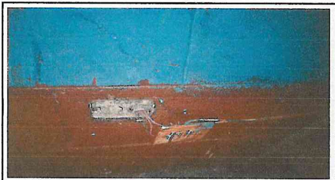
Foto 3: Reparacion de cabiado de toda la escuela
