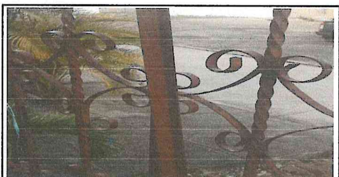
Foto 6: Pintura y reparacion de barrotes
