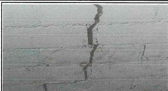
Foto 2: reparacion de muro perimetral general
